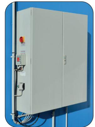
Schaltschrank mit zentraler Steuerung und Bedienelementen
